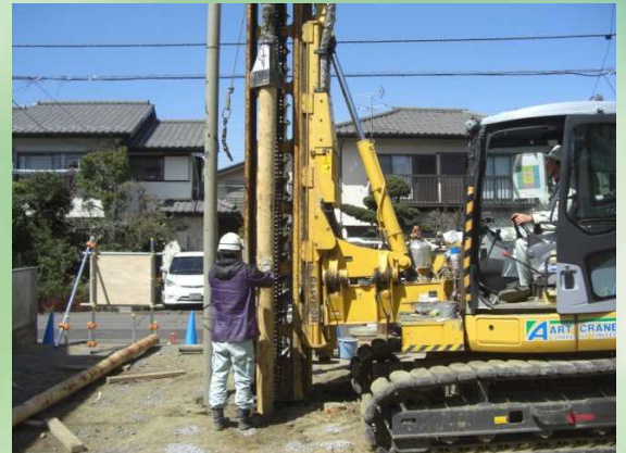
低振動・低騒音型の小型施工機械による丸太の打設状況(千葉県浦安市美浜)
